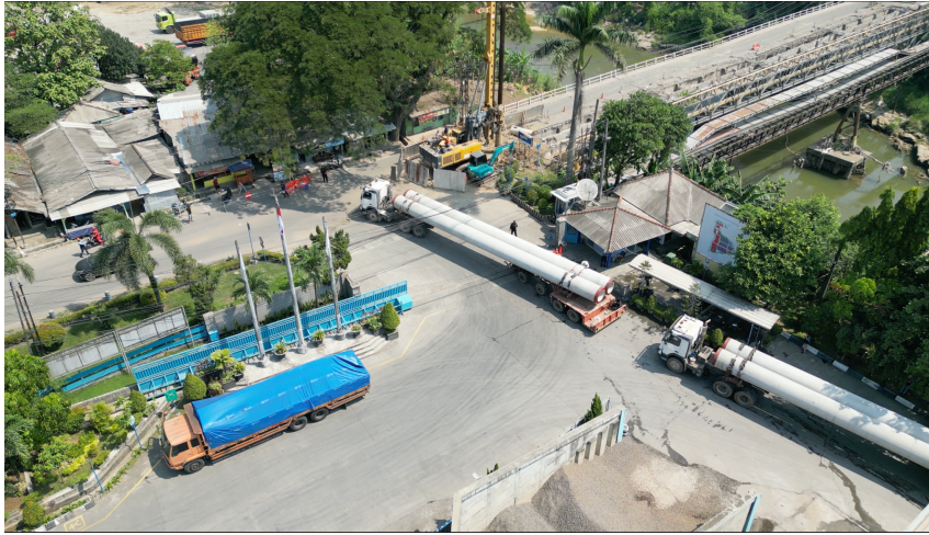
Pengiriman Tiang Pancang dari Pabrik Bogor WIKABeton
