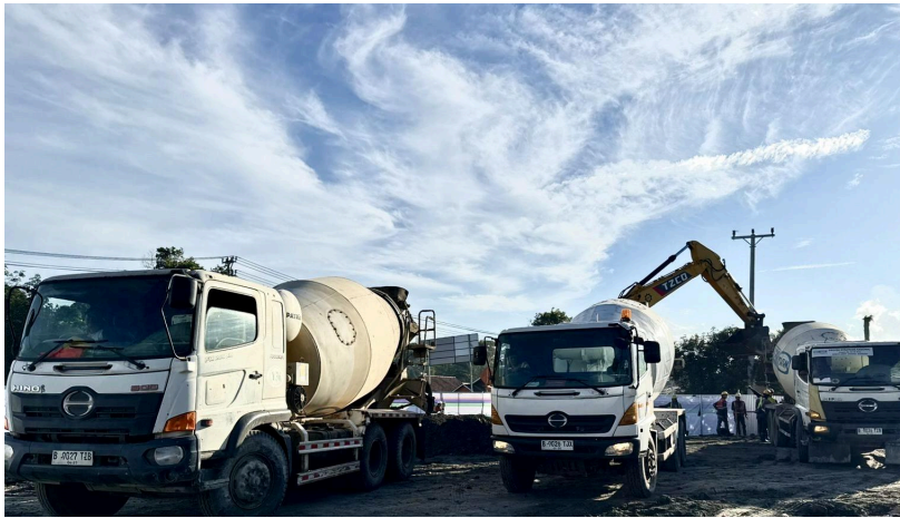
Ready Mix WIKA Beton untuk Proyek Underpass PT MIP Adaro
