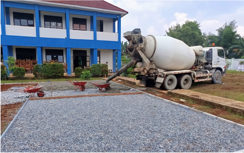
WIKA Beton Pasang Beton Porous di SMPN 4 Gunung Putri
