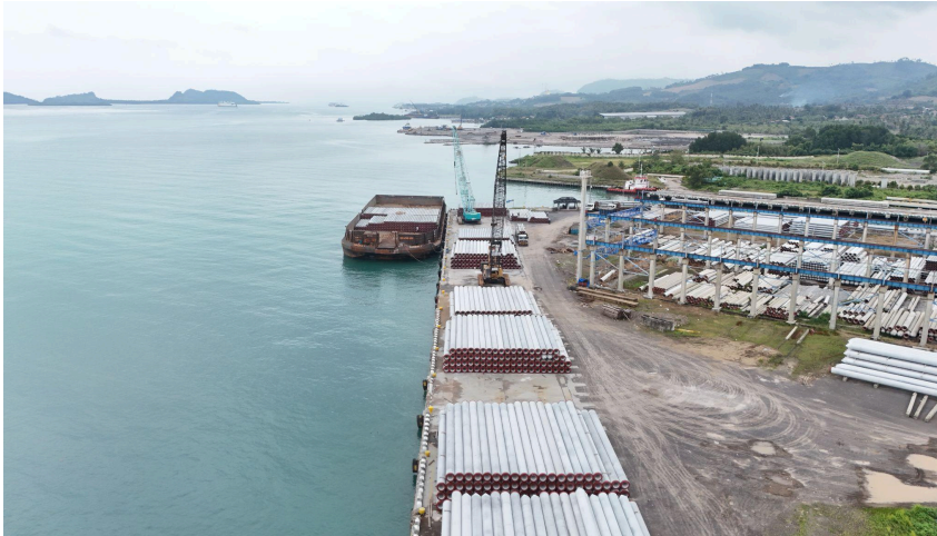
Distribusi Tiang Pancang dari Pabrik Lampung Plant Lampung Selatan
