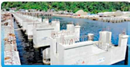
PRECAST PILE CAP
