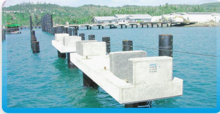
PRECAST PILE CAP
