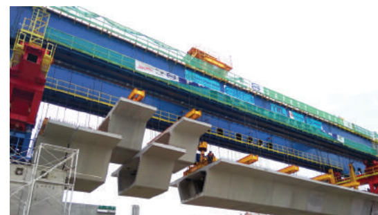
Proses erection Proyek LRT Jakarta
